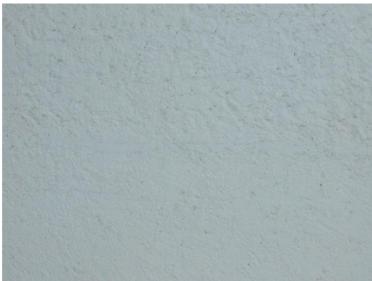
Soubassement enduit blanc
